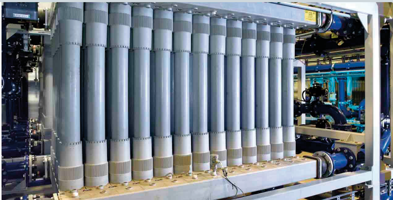
Die Mikrofiltrationseinheit hält Bakterien und Partikel aus dem kommunalen Abwasser zurück.
