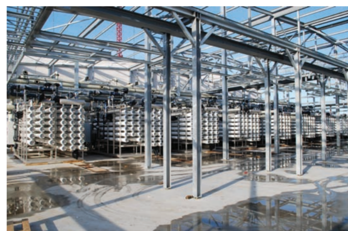
Die neue Aufbereitungsanlage, die Evides auf dem Gelände von Huntsman im Rotterdamer Hafen errichtet, arbeitet mit einer Kombination von Ionenaustauschern und Membranverfahren.
