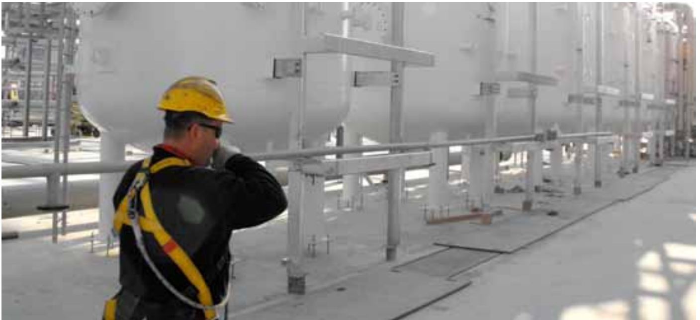
Plaatsing van de mengbedketels.
