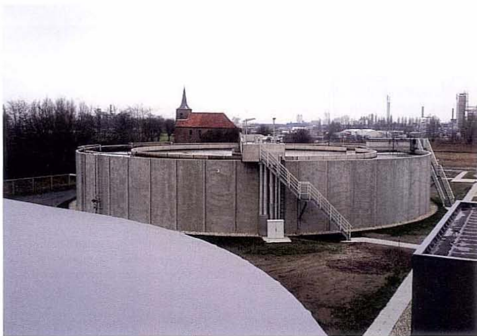
De zoutafvalwaterzuivering op industrieterrein Oosterhorn bij Delfzijl.
